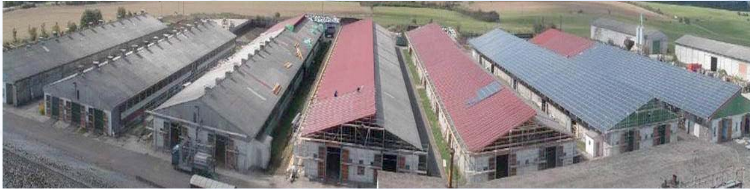
Foto: meridian Neue Energien GmbH
